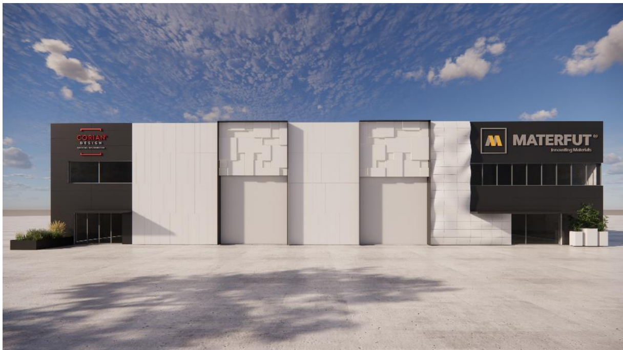
Sede di Materfut®, in Portogallo. La facciata con pannelli in Corian® Exteriors (realizzati con Corian® Solid Surface) presenta diverse possibilità di sagomatura, inclusi pannelli di forma organica creati con design parametrico; Progetto dell'architetto Alexandre Sousa Lopes; fabbricazione e installazione di Materfut®; Immagine di Materfut®, tutti i diritti riservati.
