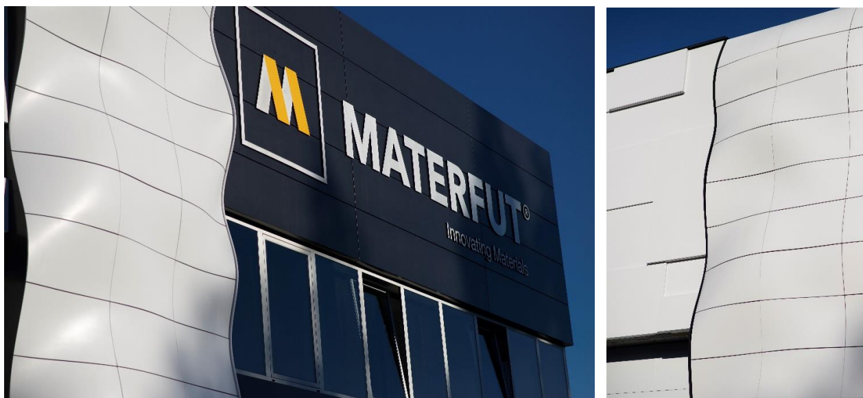
Sede di Materfut®, in Portogallo. La facciata con pannelli in Corian® Exteriors (realizzati con Corian® Solid Surface) presenta diverse possibilità di sagomatura, inclusi pannelli di forma organica creati con design parametrico; Progetto dell'architetto Alexandre Sousa Lopes; fabbricazione e installazione di Materfut®; Immagine di Materfut®, tutti i diritti riservati.
